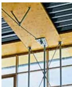
Kerto-Q ist ein Holzwerkstoff, bei dem die Faserrichtung vorwiegend in Längsrichtung verläuft, einige der inneren Furniere jedoch in Querrichtung verlaufen (ca. 20 %).
