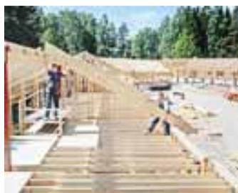
Kerto-S ist ein Furnierschichtholz, bei dem die Fasern aller Furniere in Längsrichtung verlaufen. Es ist deshalb besonders für tragende, stabförmige Konstruktionsteile geeignet.
